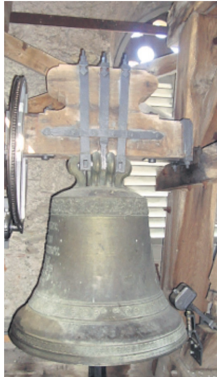
Glocke mit Schlaghammer für die Stundenschläge
